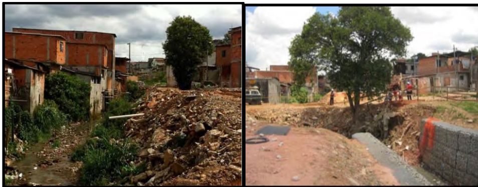
Figura 4. Área do Futuro Parque Linear do Sapé Figura 5. Obras no córrego do Sapé
