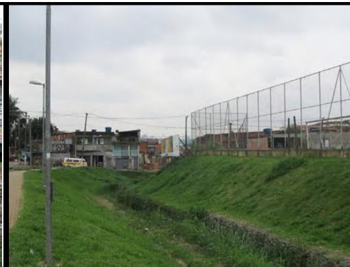
Figura 7. Córrego Sapé e Quadra Esportiva.
