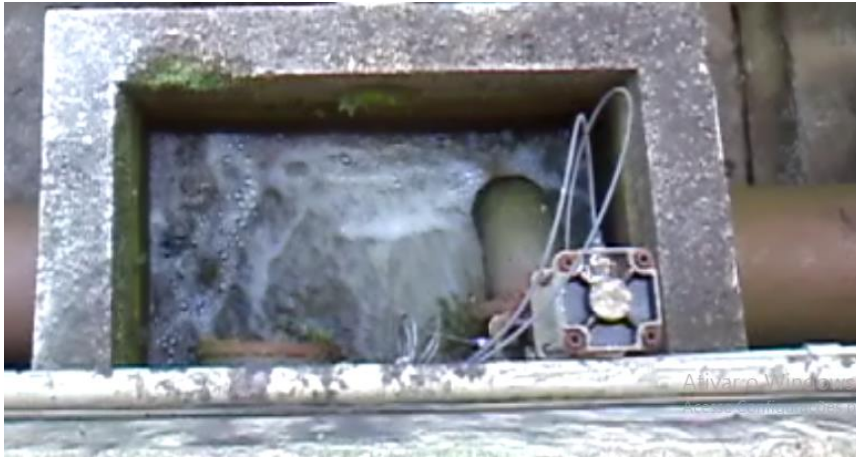
Figura 5 Efluente Tratado (clarificado)
