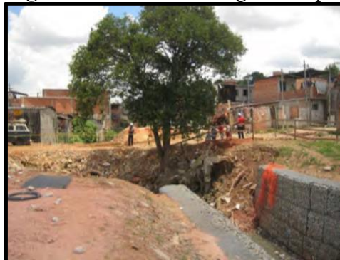
Figura 4. Obras no córrego do Sapé.
