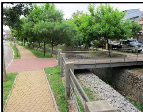
Figura 5. Canalização do córrego e passeios permeáveis.
