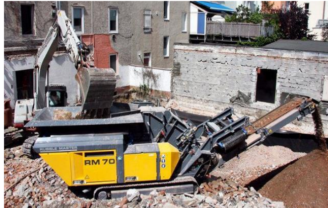
Fig 2 – Usina do tipo Móvel
